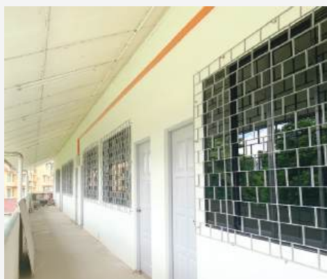
Block B新建宿舍走廊
